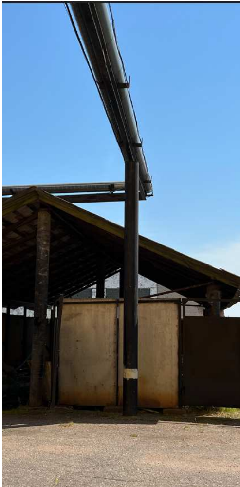
1 pav. Esamos estakados konstrukcijos.
